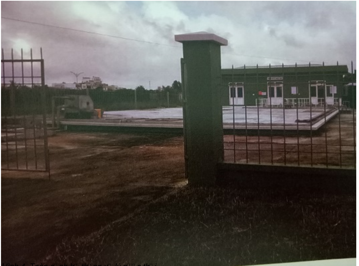
Hình 4. Toàn cảnh hệ thống xử lý nước thải
